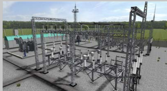
Районная понизительная подстанция 110/35/10кВ
